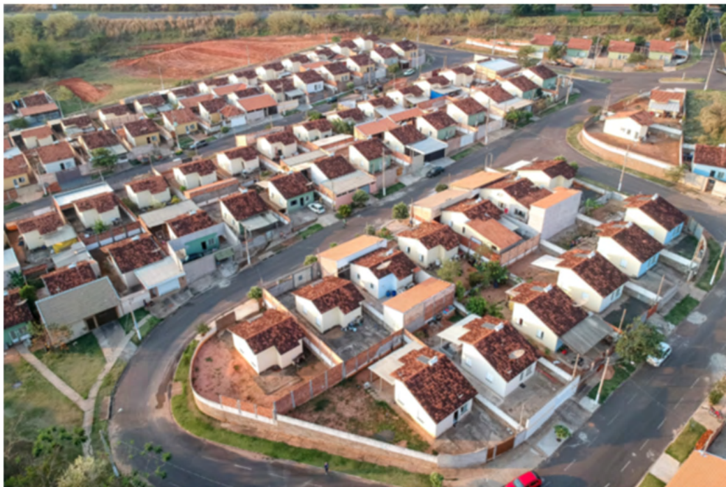
Vista aérea de la obra de construcción de viviendas estandarizadas del programa «Minha Casa, Minha Vida», en la ciudad de Pompeia, en el estado de São Paulo, Brasil. Fuente: Adobe Stock Images, AlfRibeiro
