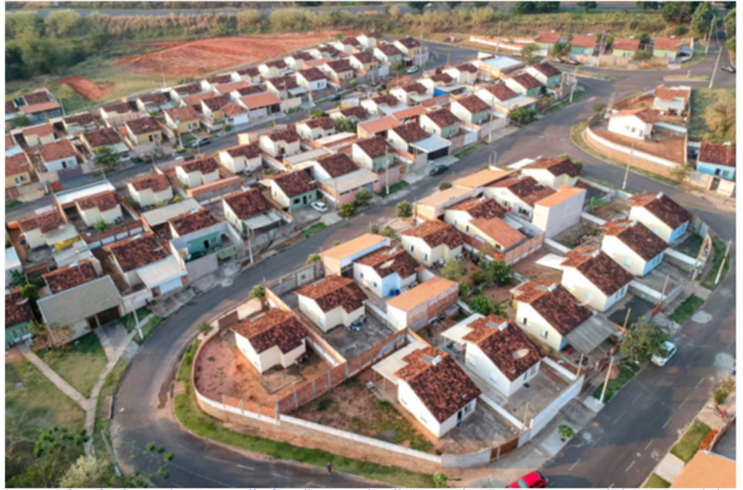
Luftaufnahme der Baustelle für die Standardhäuser des Programms „Minha Casa Minha Vida“ in der Stadt Pompeia im Bundesstaat São Paulo, Brasilien. Quelle: Adobe Stock Images, Alfribeiro
