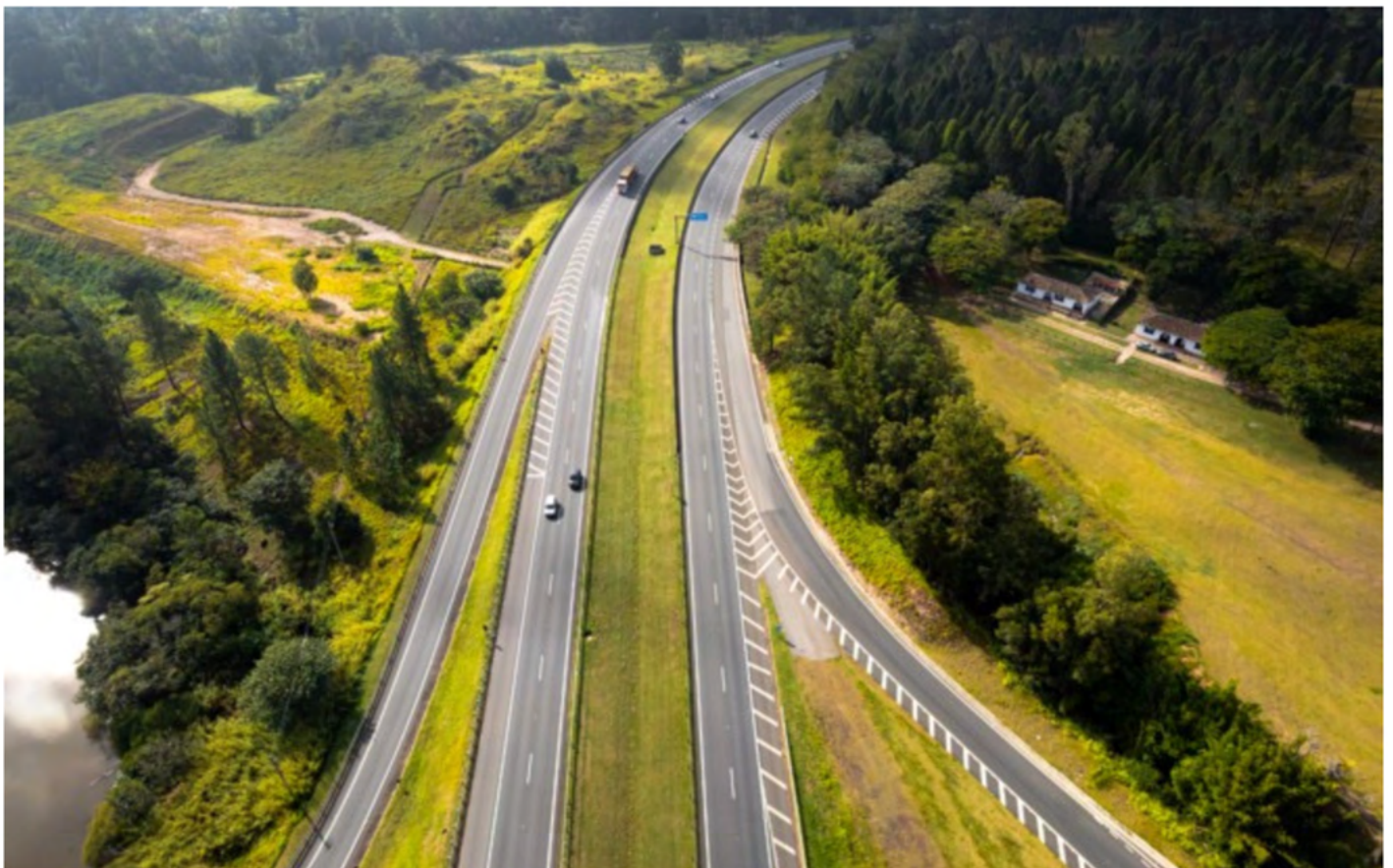
Vista aérea de la autopista Dom Pedro en la ciudad de Campinas, Brasil. Fuente: Adobe Stock Images, Paulo
